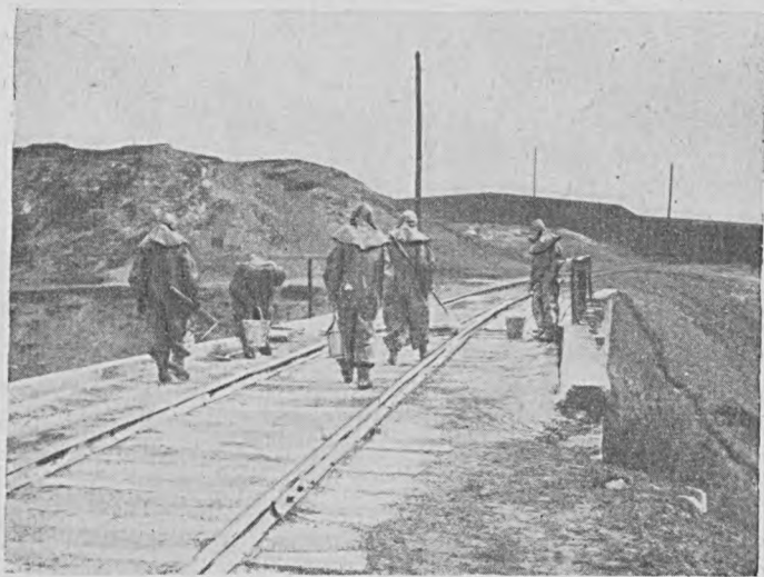
Rys. 32. Odkazanie toru kolejowego.
