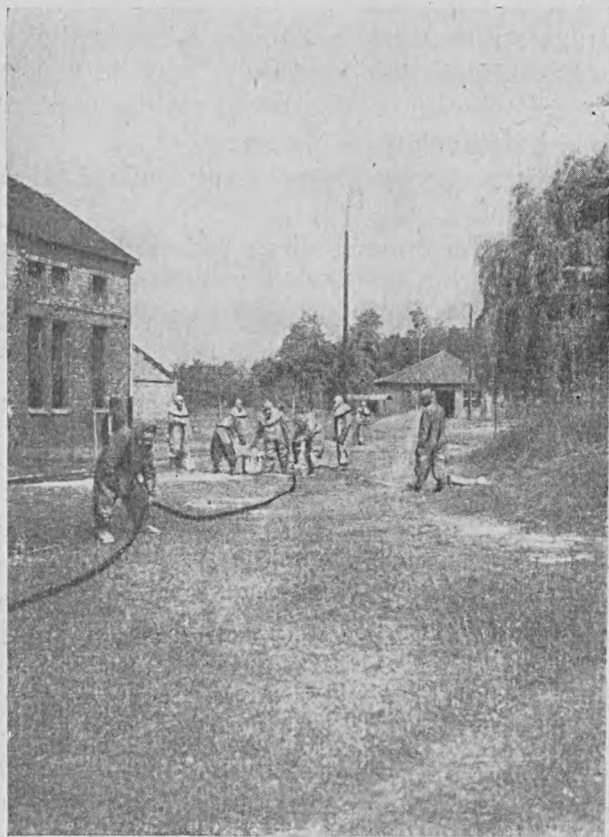
Rys. 39. Odkażanie aparatem „PG” lub „PGD”. Patrol odkażający obsługuje aparat. Patrol pomocniczy — hydrant, donosi chlorek itp.
