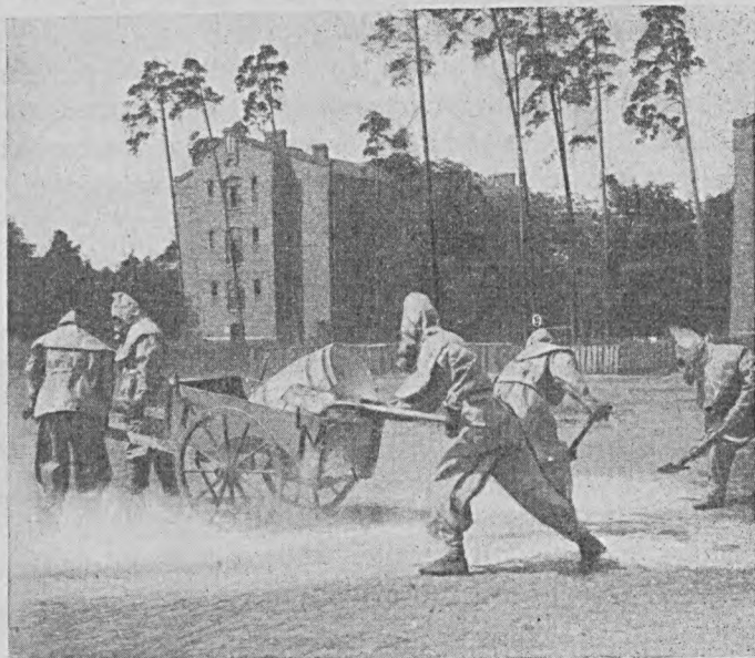
Rys. 34. Odkazanie terenu. Wykorzystanie wózka do przewożenia wapna cholorowanego w beczce, z której jest ono bezpośrednio czerpane do rozrzucania.
