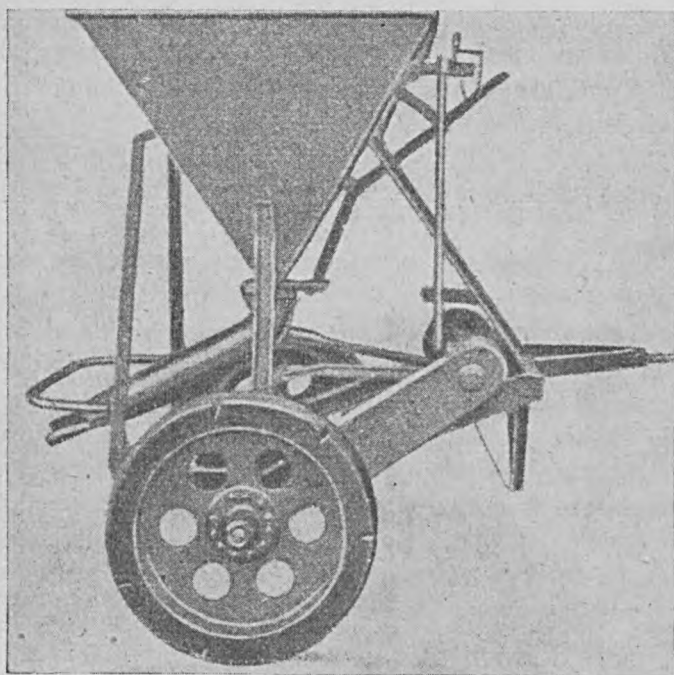
Rys. 46. Przyczepka dwukołowa z siewnikiem rzutowym (tuleja).
