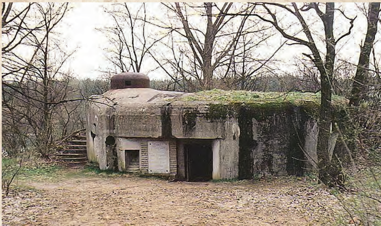
Schron nr 1 Punkt Oporu Nowogród
