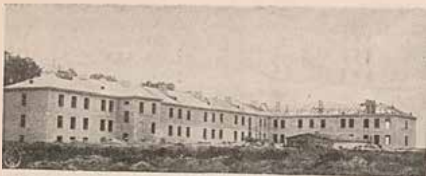
Budowa koszar w Snowie
